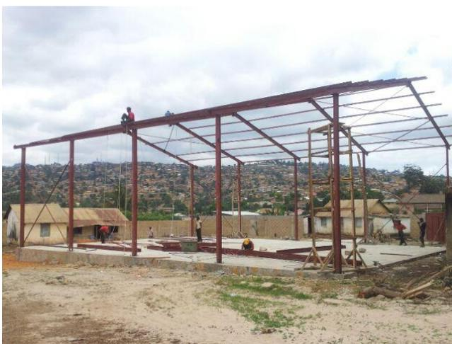
Le bâtiment repose sur une dalle puis une charpente métallique a été posée. Le toit est recouvert de tôles et les murs ont été élevés en briques. Le Diocèse de Matadi a couvert une partie des frais de construction et il sollicite aujourd'hui l'aide de l'Association Kimpangi et de ses généreux donateurs pour les derniers travaux et le bon fonctionnement de la menuiserie.
