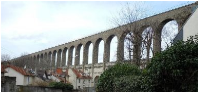
Les ponts-aqueducs d'Arcueil et de Cachan
