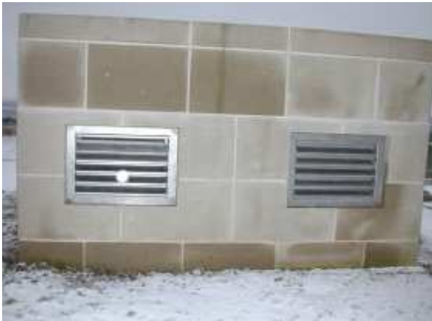
Cheminée d'aération avec bouche d'aspiration orientée vers le nord
