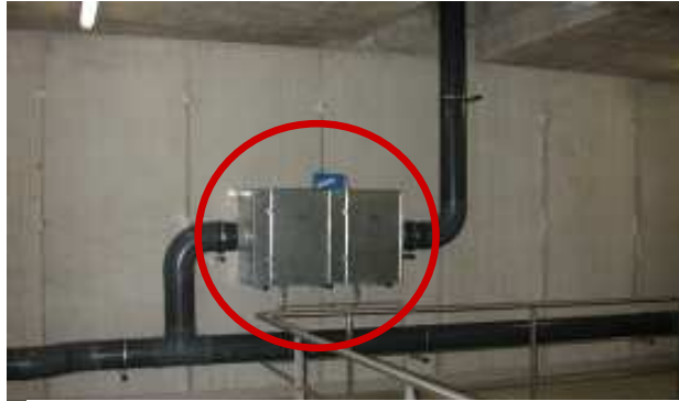
Systeme d'aération muni d'un filtre à air
