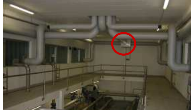
Systeme d'aération muni d'un filtre à air
