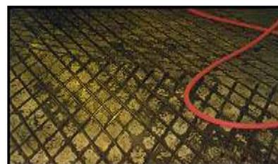
Cette dalle est adapté pour la manipulation des porcs et des vaches laitières Une autre bonne surface est d'imprimer le motif de maille en métal déployé dans le béton humide Faire un timbre hors du treillis métallique soulevé élargi avec une largeur d'ouverture de 2,5 cm
