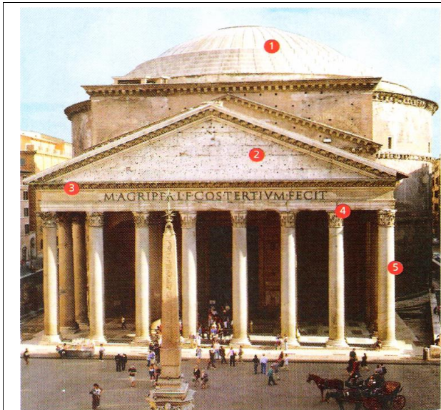
Le Panthéon de Rome, temple romain du II e siècle (1 coupole, 2 fronton, 3 entablement, 4 chapiteau, 5 colonne).
